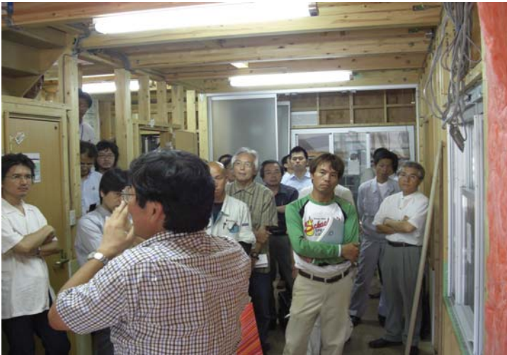
後半は、建てられている住宅の壁を利用して、断熱材を施工。開口部周りの気密、防水等も実技指導された。
