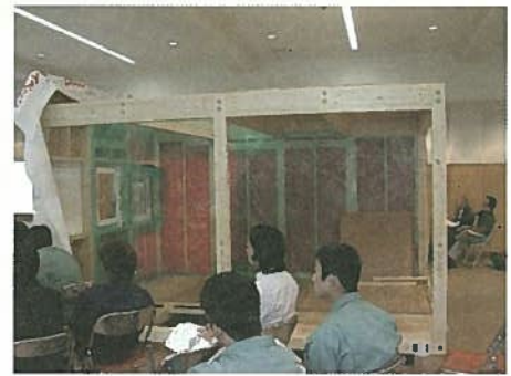
高断熱高気密の基本から断熱耐震リフォームの施工技術を実物大模型で研修 (研修は合板気密工法です)
