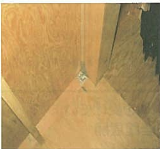
合板気密工法 気流止め
